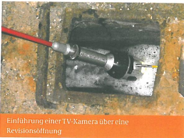
Einführung einer TV-Kamera über eine Revisionsöffnung
