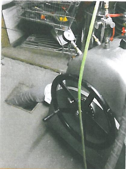
Einbautrommel für das Liningverfahren
