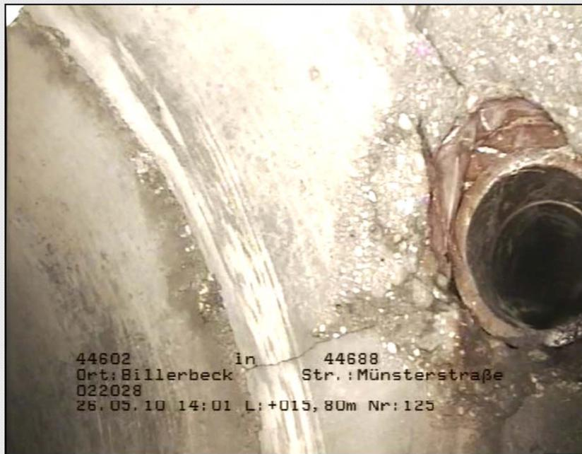
Abbildung 8: Längsriss, schadhafter Anschluss
