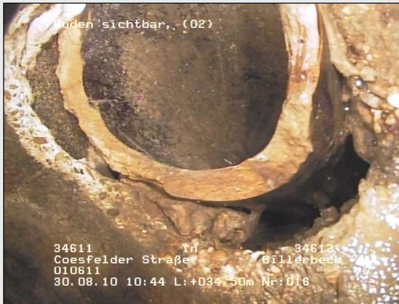
Abbildung 6: Boden sichtbar
