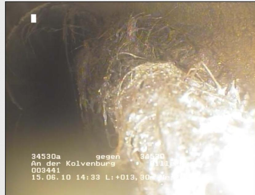
Abbildung 5: starker Wurzeleinwuchs
