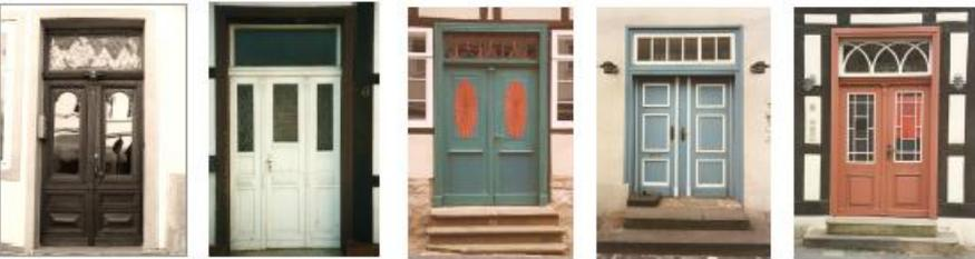
mit heutigen Materialien entwickelte Türen mit einem oder zwei Flügeln und mit zentralem oder seitlichen Durchblick
