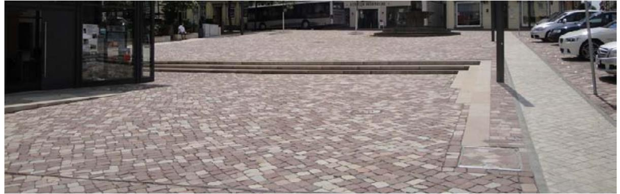
Bsp. Großsteinpflaster Oberfläche gesägt
