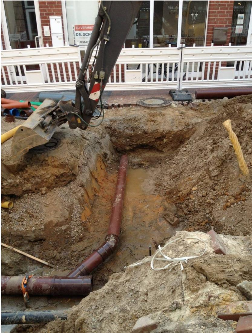
Anschlußleitung auf Betonabdeckung
