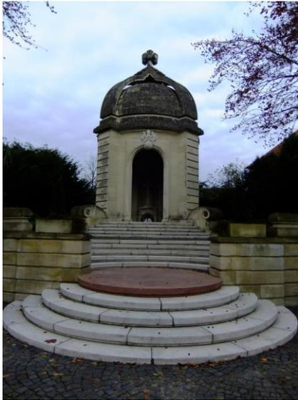
Ein weiteres Denkmal, das nach dem 1. Weltkrieg errichtete Kriegerehrenmal, ist ebenfalls ein Bauwerk aus Baumberger Sandstein, dessen Kuppeldach aus dem gleichen Material gefertigt wurde. Das Kriegerehrenmal ist rundum der Witterung ausgesetzt und bedarf dauerhafter Unterhaltung. Aktuell ist eine Grundsanierung nötig.
