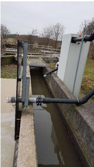
**Abbildung 12** Dosierstelle des Fällmittels
