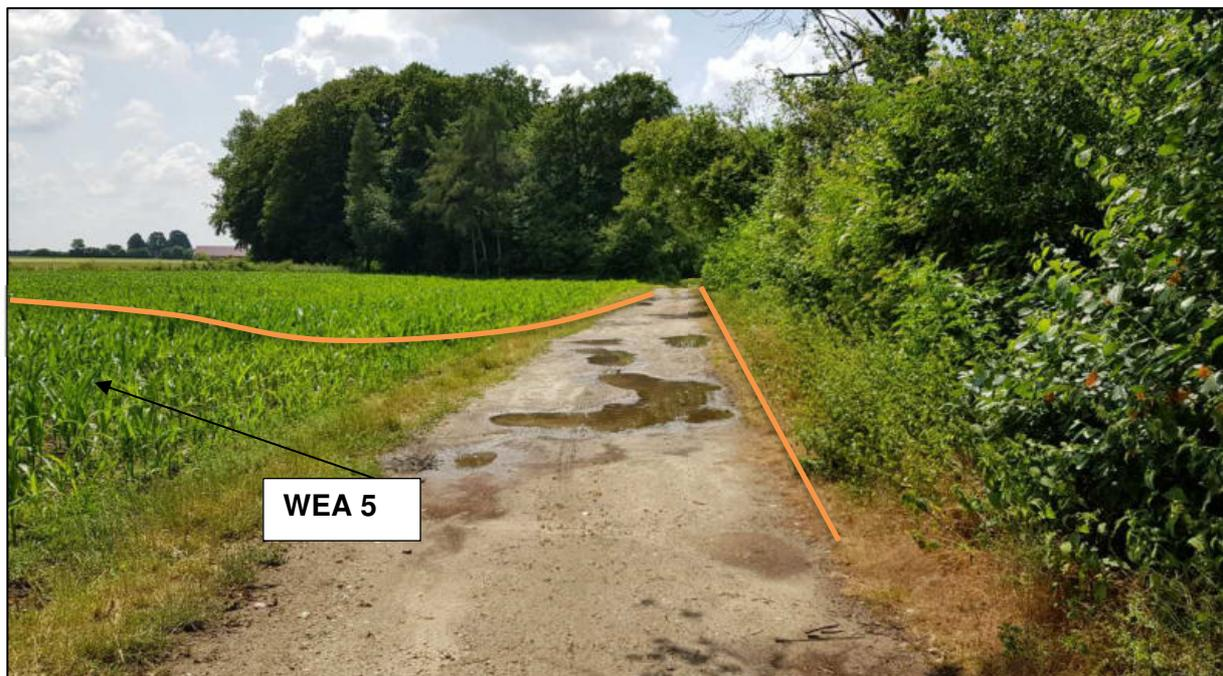
Abbildung 26: Geplante Betriebszufahrt von der WEA 5 Richtung Süden, der vorhandene Weg soll dauerhaft auf 4 m ausgebaut werden.
